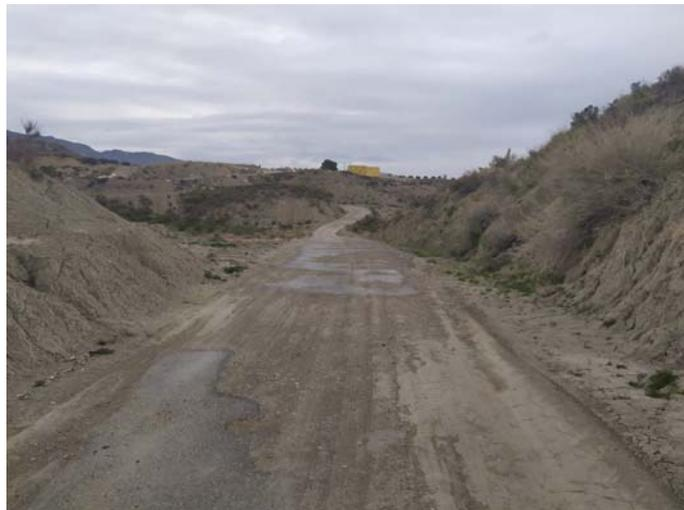
Debido a los agentes meteorológicos y al tráfico de vehículos el desgaste del camino es innegable, la falta de limpieza y la inexistencia de cunetas en algunos puntos, junto con la falta de la capa de rodadura como plataforma para expulsar el agua del camino hace que el deterioro del mismo se vea potenciado día a día.
